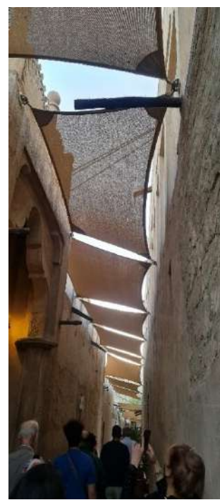
ایجاد سایه در گذرهای قدیمی برای تلطیف دمای محیطی عکس: سنبل حاتمی
